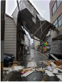
台風21号通過後の当事務所 N弁護士の自宅前の状況 (左下の車が損傷)
